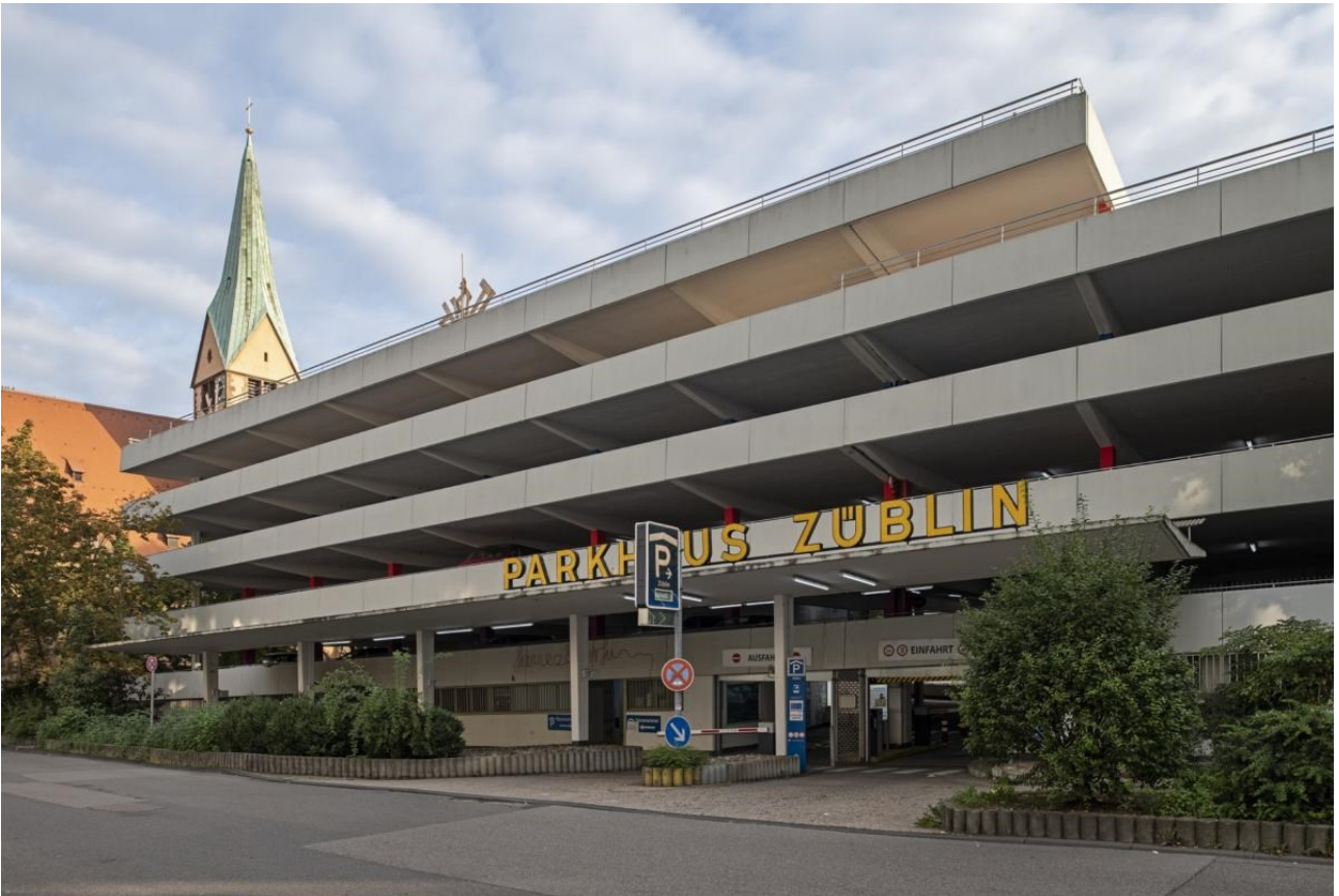
Züblinparkhaus in Stuttgart
