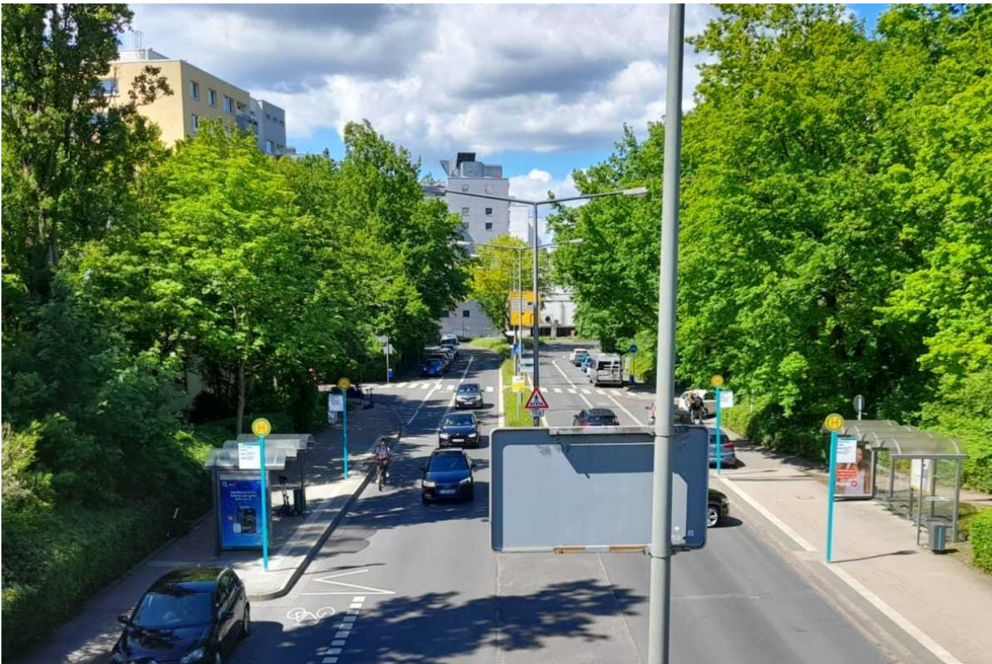
Autofahrstraße in der Nordweststadt
