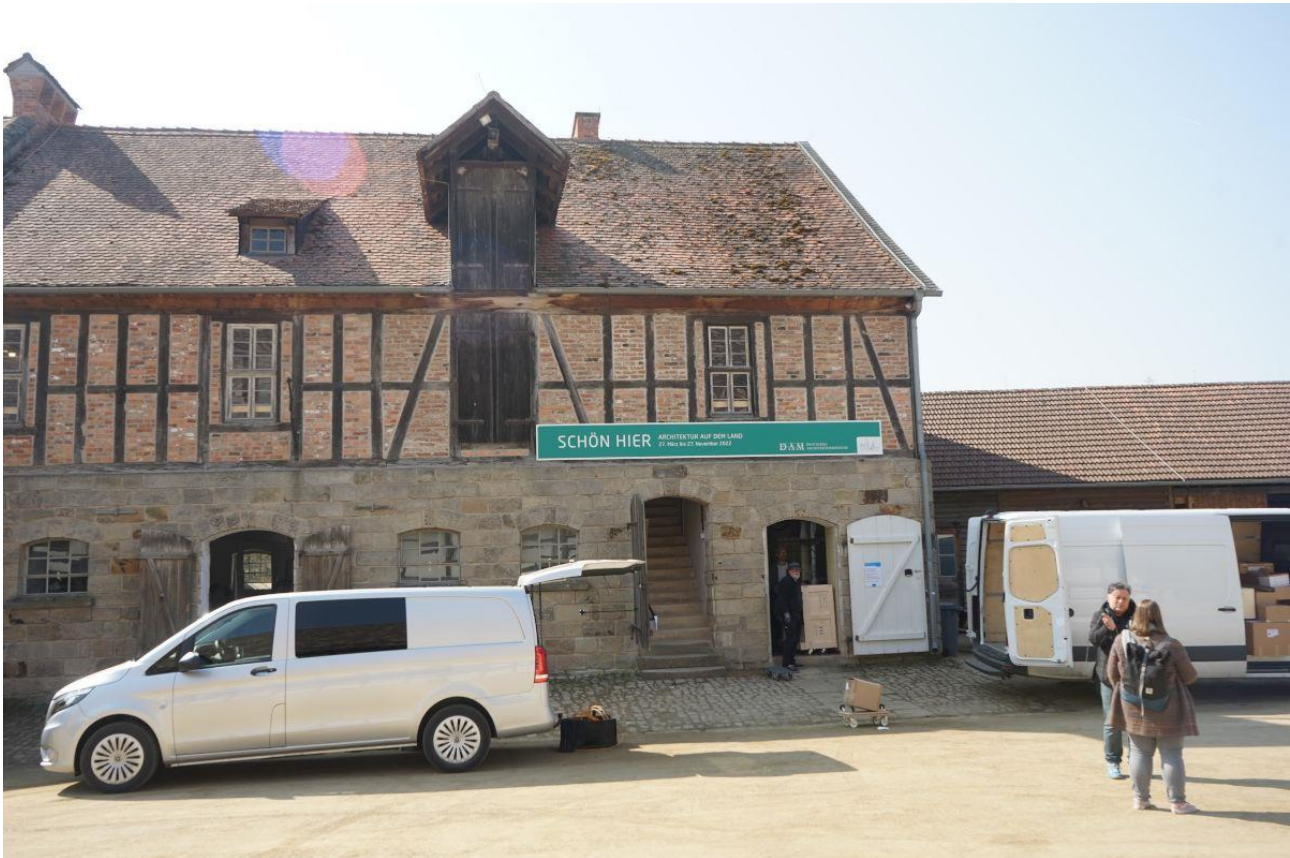
Treppenaufgang und Eingang zur Ausstellung. wiedererrichtete Hofanlage aus Emstal-Sand
