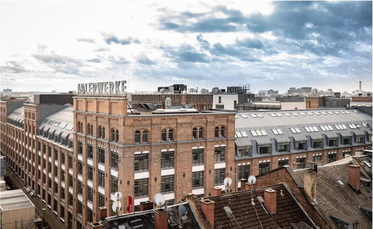
Außenansicht Adlerwerke, Kleyerstraße, Foto (c) Salome Roessler
