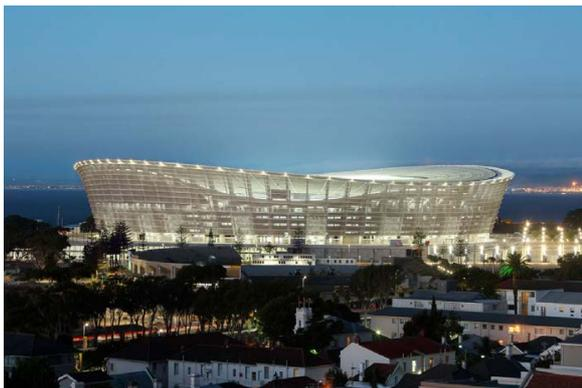
Beim Bau des Green Point Fußballstadions in Kapstadt wurden auch die optischen Möglichkeiten der Textilkonstruktion durch eine besondere Beschichtung des naturweißen Glasfasergewebes ausgenutzt. Diese bewirkt, dass tagsüber Sonnenstrahlung an der Textilhaut reflektiert, so dass diese blickdicht wirkt. In der Nacht kehrt
