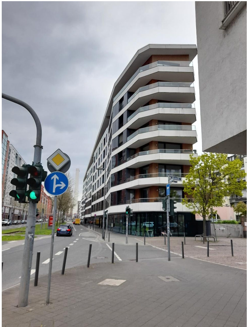
Aktiv-Stadthaus Speicherstraße, Foto © Kulturrexpress
