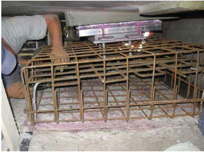
Die seit April unter der Alten Brücke stattfindenden Instandsetzungsarbeiten an dem Stahlüberbau werden Ende dieser Woche abgeschlossen. Die vier stark korrodierten Lager des Stahlüberbaus wurden ausgewechselt und auf neu betonierten Lagersockeln eingebaut. Diese Lager sind die Kontaktpunkte zwischen Über- und Unterbau, also der eigentlichen Brücke und deren Pfeilern. Sie müssen so beschaffen sein, dass sie die
