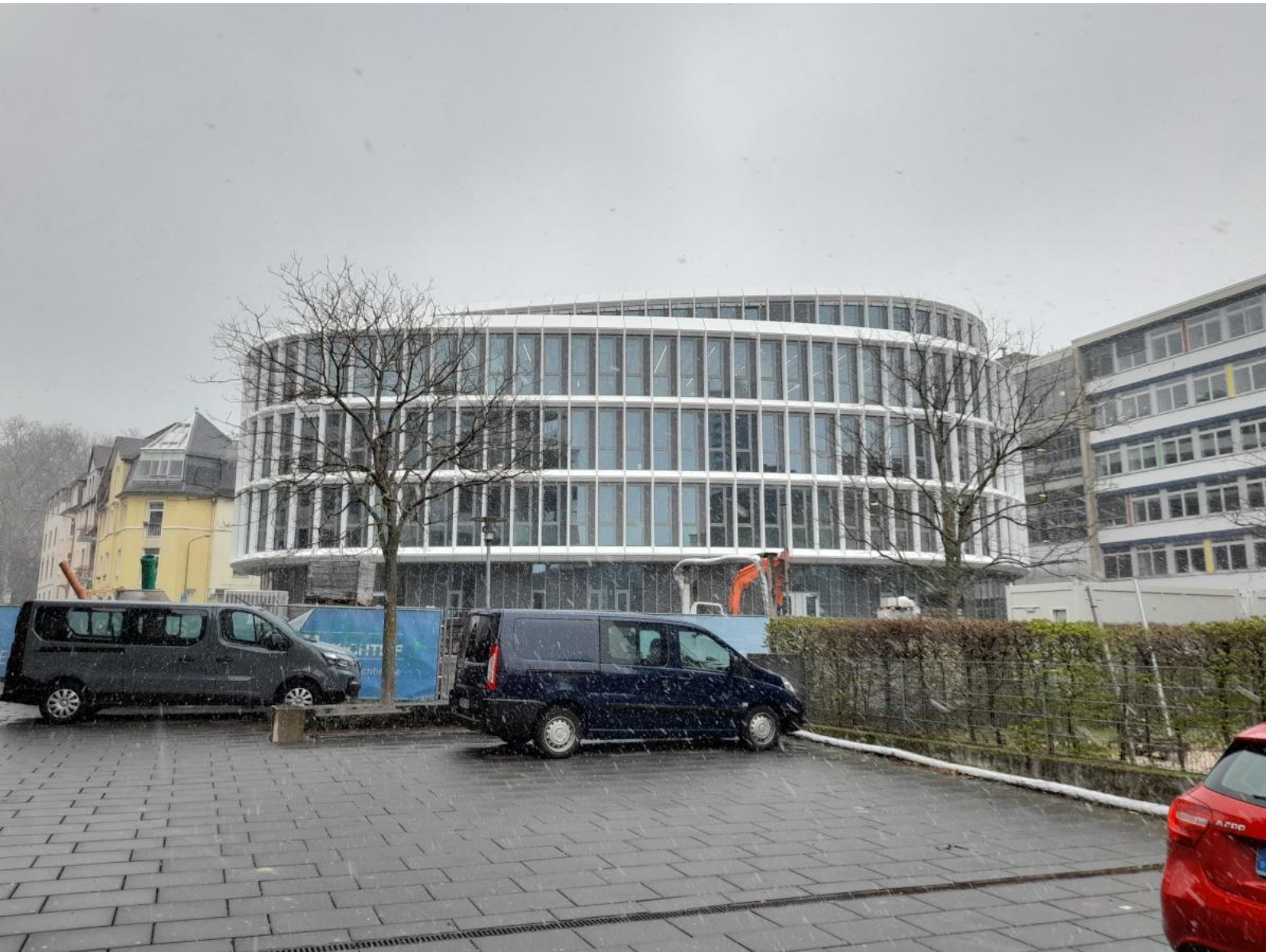
Neues Mehrzweckgebäude der Frankfurt UAS vor Fertigstellung, April 2022
