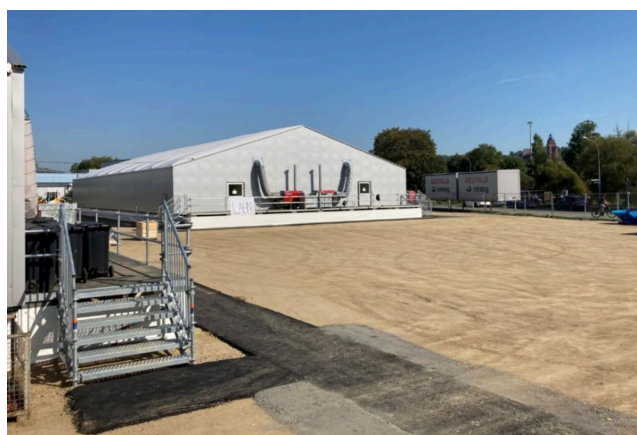
Zwischen Dill und Lahn liegt die neue Notunterkunft in Wetzlar. In zwei Leichtbauhallen sind Schlafräume eingerichtet, in einer weiteren Aufenthaltsraum, Kochgelegenheiten und Speisesaal Foto: Ulrike Kammler/ Lahn-Dill-Kreis
