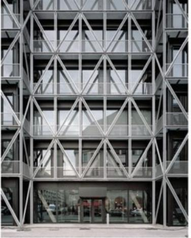
Die «Höhenlinien»: Ein diagonal gespanntes, selbsttragendes Netz aus Stahlprofilen bildet die äußere Hülle und ist zugleich ein auf allen Etagen vorhandener Balkonriegel.
