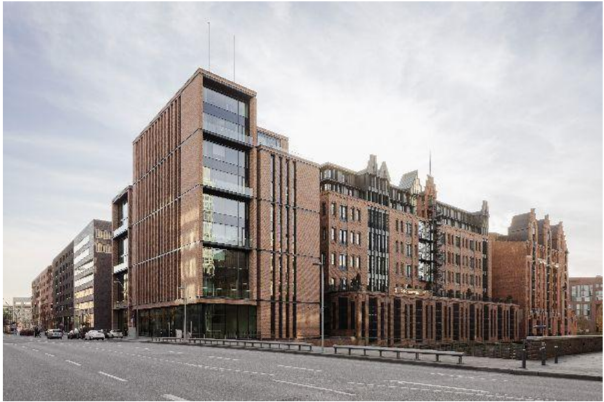
Gebr. Heinemann: Blick von der Shanghaibrücke, Foto © Marcus Bredt
