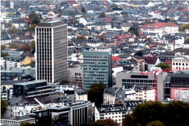
Kernsaniertes Turmcenter in Frankfurt an der Eschersheimer Landstraße
