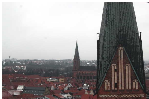
Blick vom Wasserturm auf die St. Johanniskirche und St. Nicolai im Hintergrund
