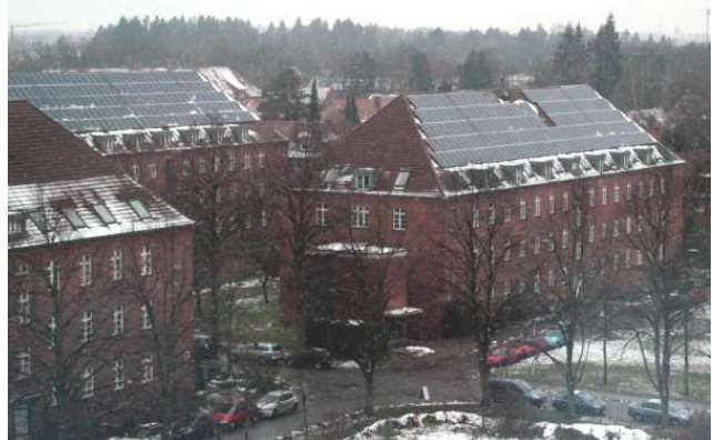
Mehrere der Bestandsbauten aus Backstein wurden auf den Dächern mit Solar-Anlagen zur Stromerzeugung bestückt.
