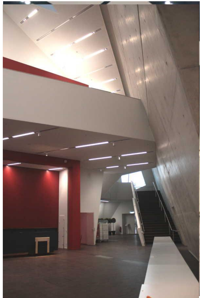
Treppenaufgang im EG mit Seitenwand in Sichtbeton
