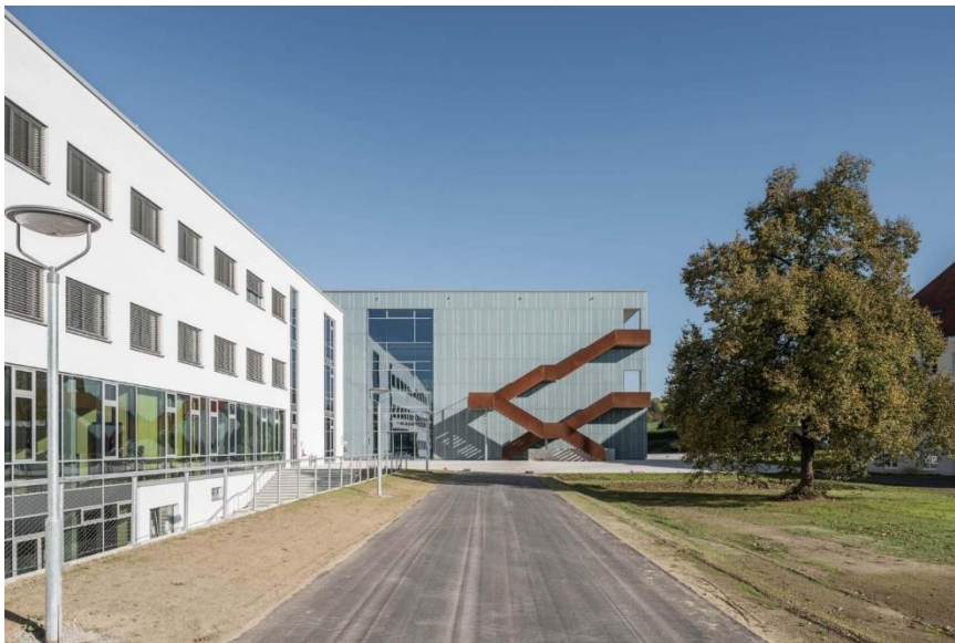
Hochschule Weihenstephan Freising, Dewan Friedenberger Architekten GmbH
