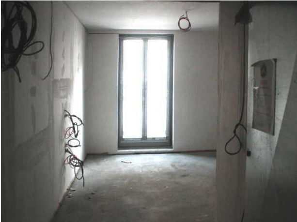
Hotelzimmer im Bau
