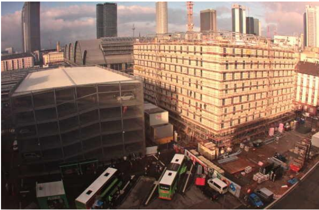
Baustelle im Dezember 2017
