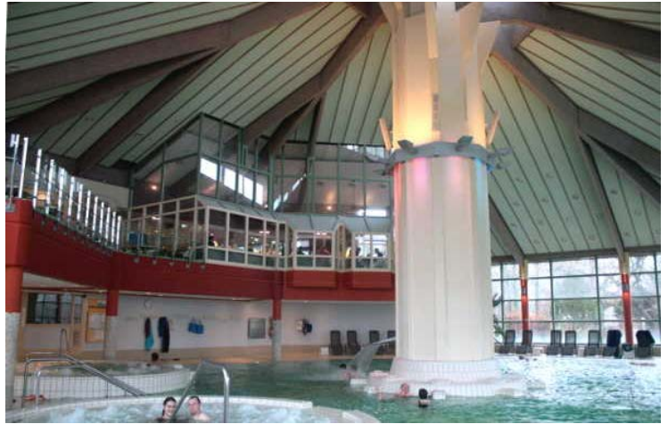
Kegeldach und Mittelstütze, Blick ins Solebad
