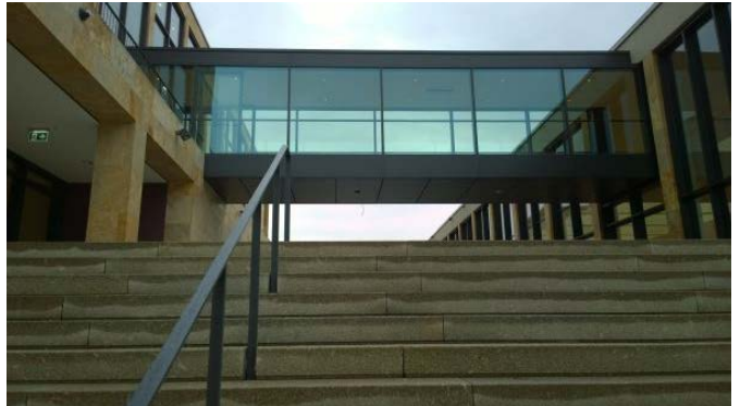
Öffentlicher Durchgang zwischen Halle 1 und 2
