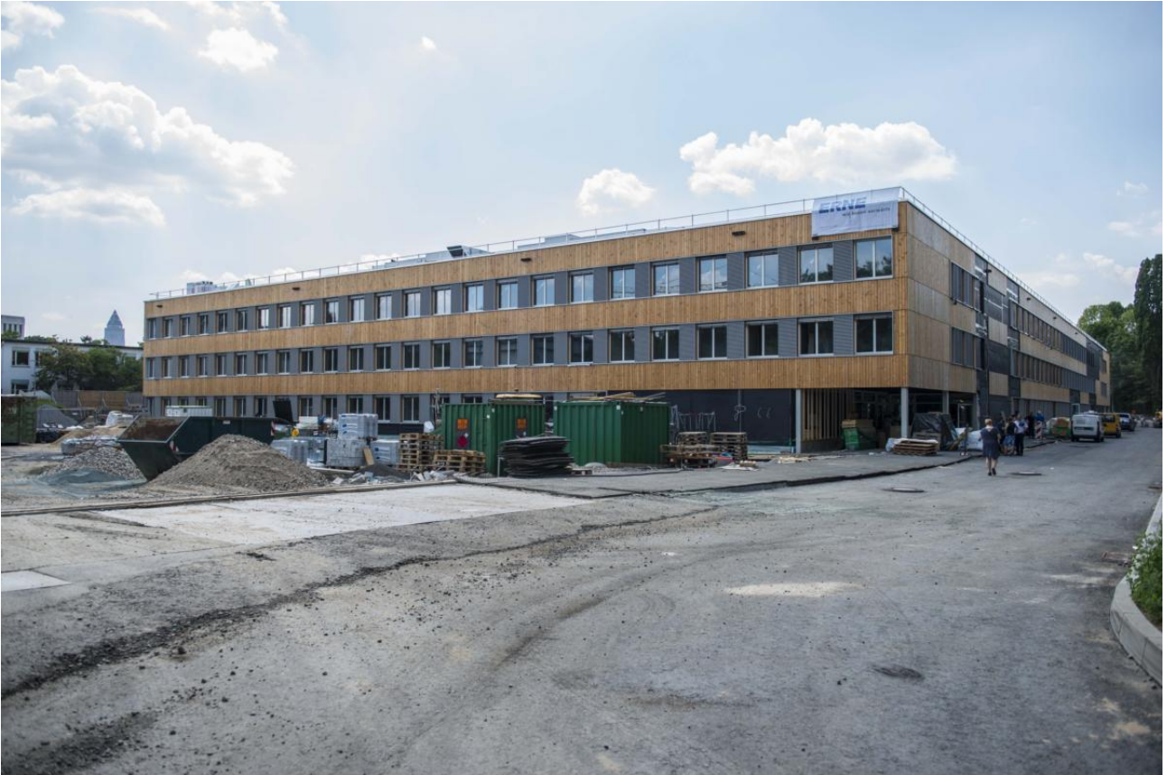
Richtfest Schulcampus Westend: Außenansicht des Holzmodulbaus
