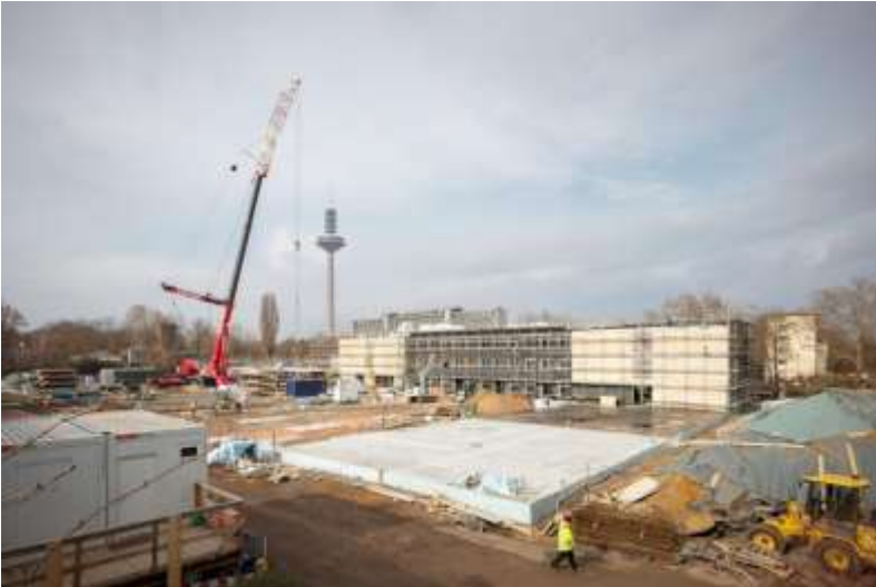
Blick auf die Baustelle
