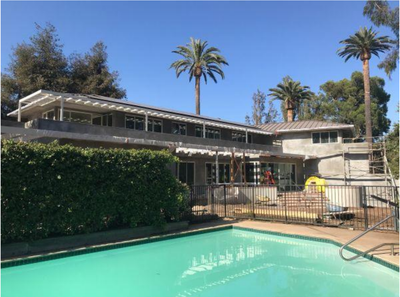
Ansicht der Baustelle, Foto (c) Berthold Leibinger Stiftung
