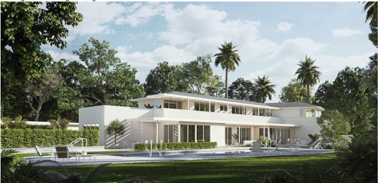
Thomas Mann Haus nach Renovierung, Animation (c) rebuild.ing GmbH - H2S architekten
