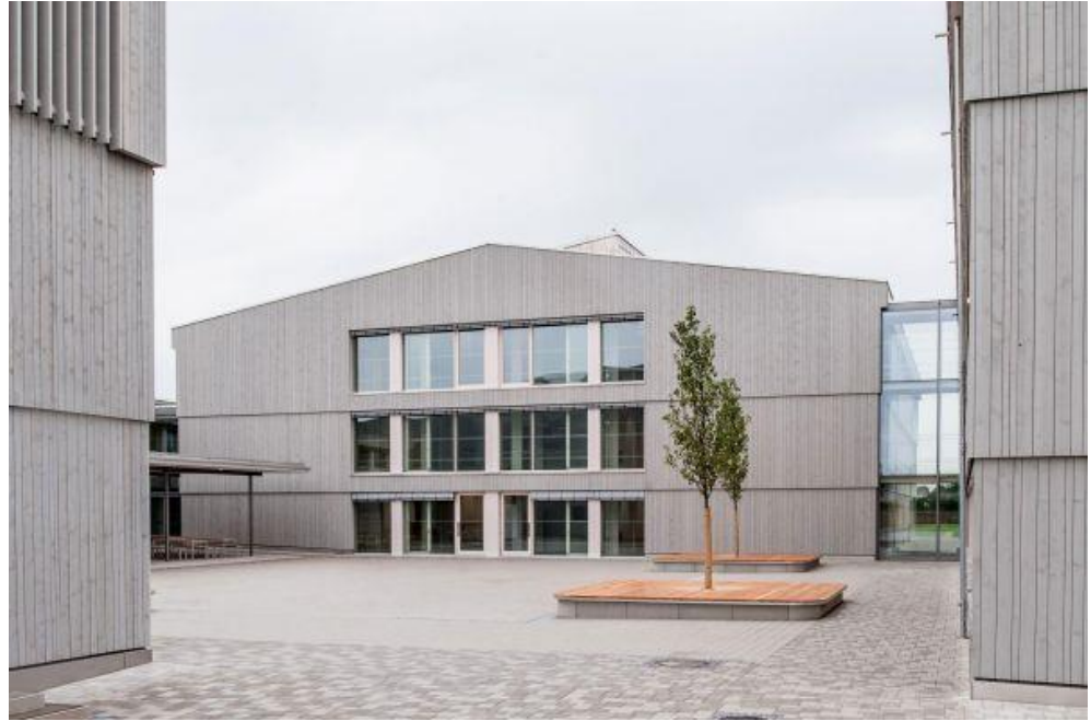
Der Innenhof des Schmuttertal-Gymnasiums in Diedorf, Foto © Carolin Hirschfeld
