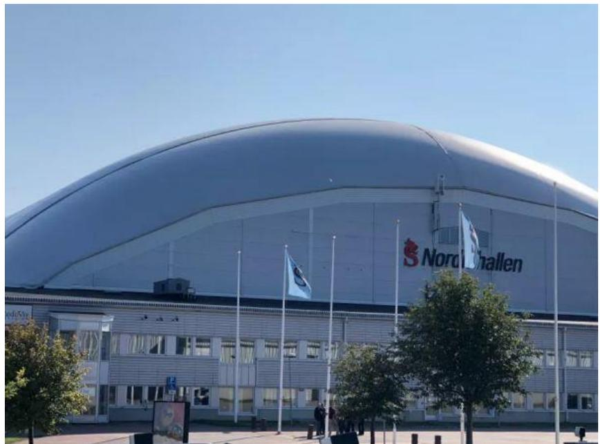
Für schwere Schneemassen wurde auf dem Dach der Nordic-Hallen in Sundsvall ein neun Meter hoher Airdome erbaut.
