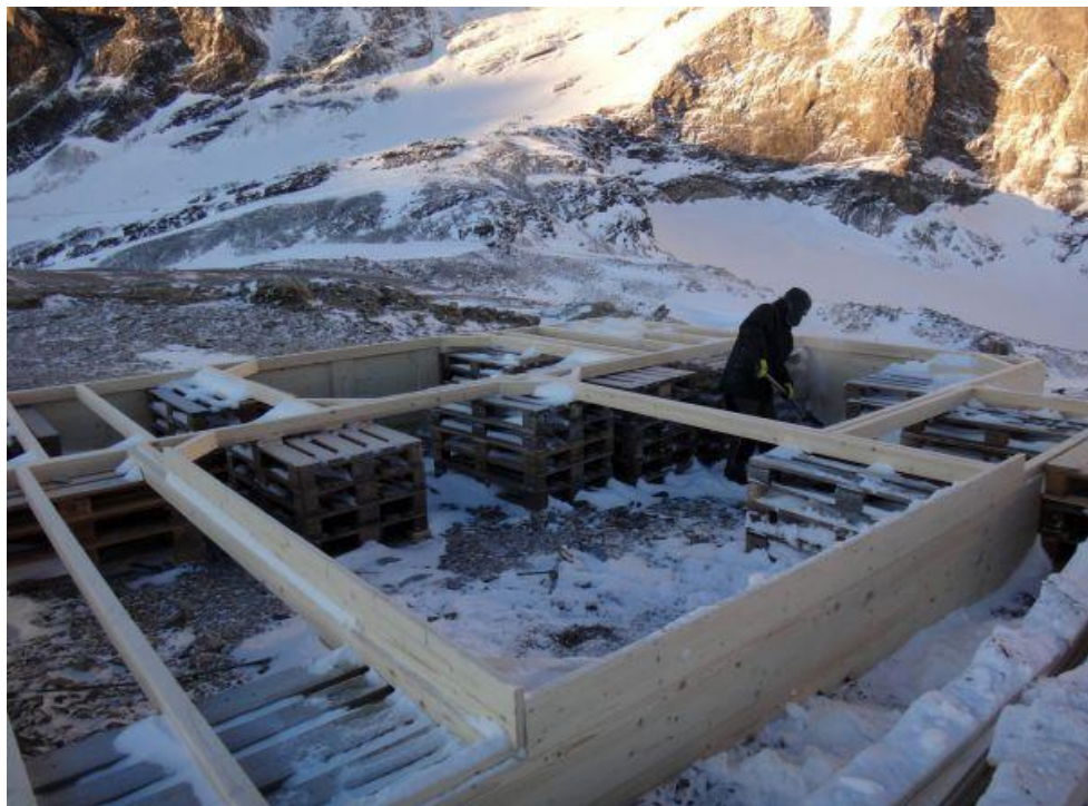
Der Sockel wird überprüft
