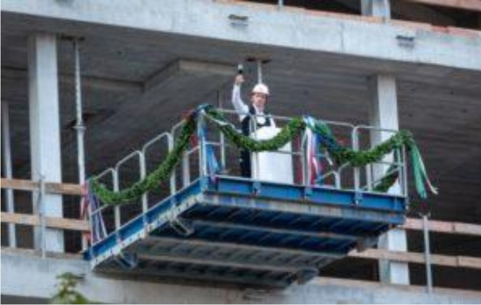
Richtfest am Axel Springer-Neubau: Thomas Schnetzer, Oberpolier der Ed. Züblin AG, wünschte dem Haus in seinem Richtspruch „Glück und Segen“, Foto (c) Dominik Tryba
