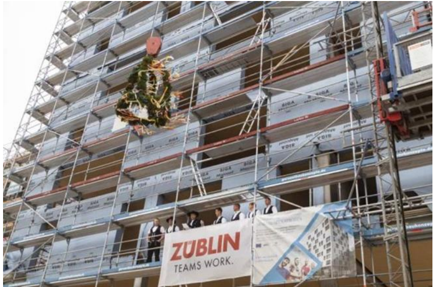
Richtfest für Deutschlands höchstes Holzhochhaus SKAIO
