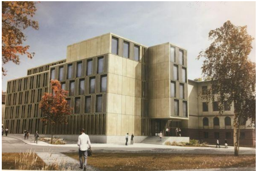
Entwurf agn für Gebäude 7 der Frankfurt UAS, Visualisierung (c) agn Niederbergerhaus & Partner GmbH
