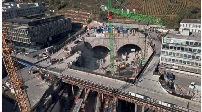
Baustelle Stuttgart 21 aus der Luft, Foto (c) ZDF/René Munder
