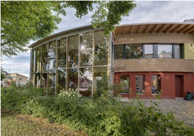
IBN-Gebäude Westseite, Foto © maximilian mutzhas fotografie
