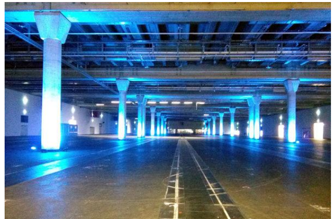
Runde Stützen und dazugehörige Betonpilze beim Blick in die leere Halle 12.0
