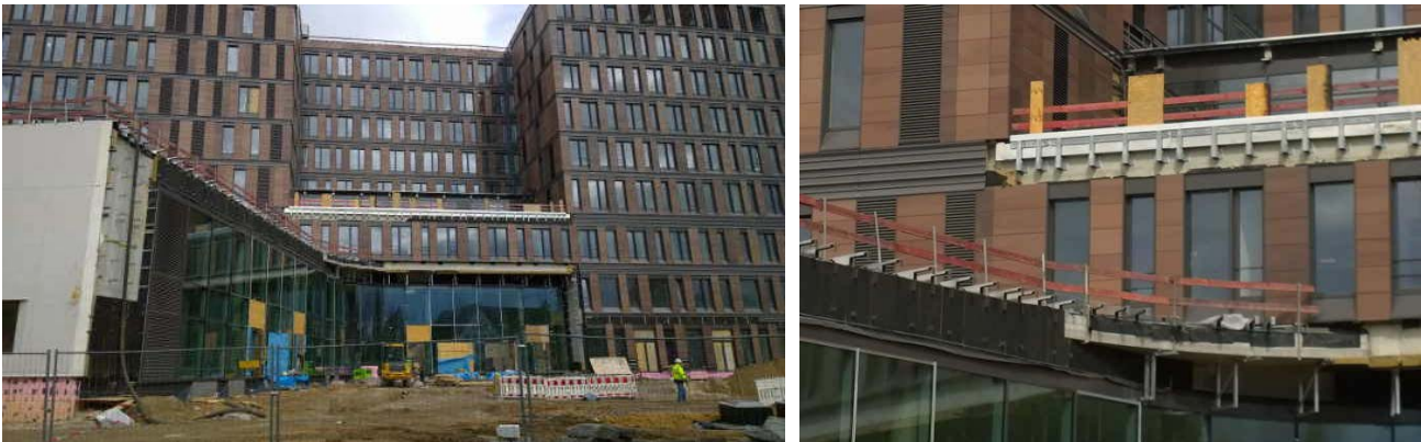
Baustelle aufgenommen am 18. April 2017
