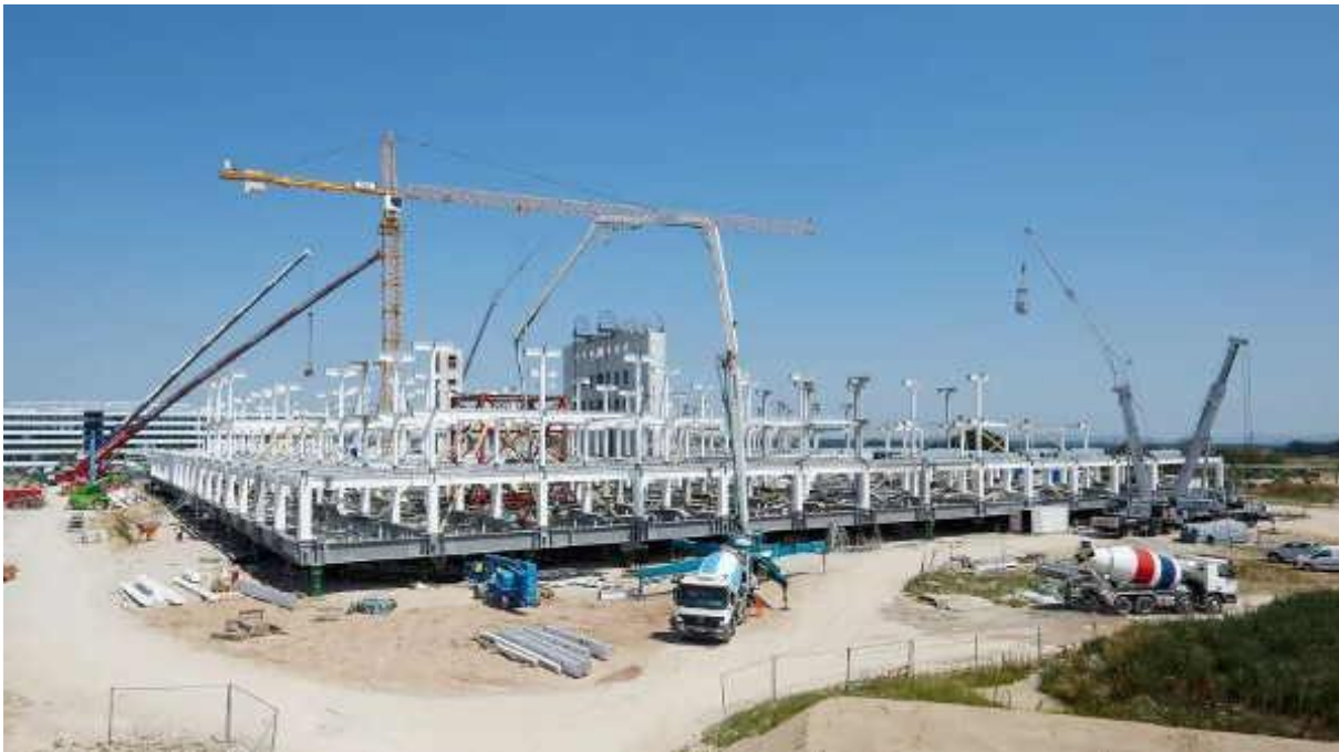
12.000 t Pressenhub am Projekt „ARENA“ von adidas (Copyright: Ed. Züblin AG)
