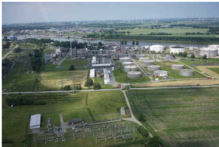
Innovatives Pilotprojekt: Sektorenübergreifender Ansatz im Multi-Megawatt Hybridspeicherprojekt in Brunsbüttel, Foto (c) Wind to Gas Energy
