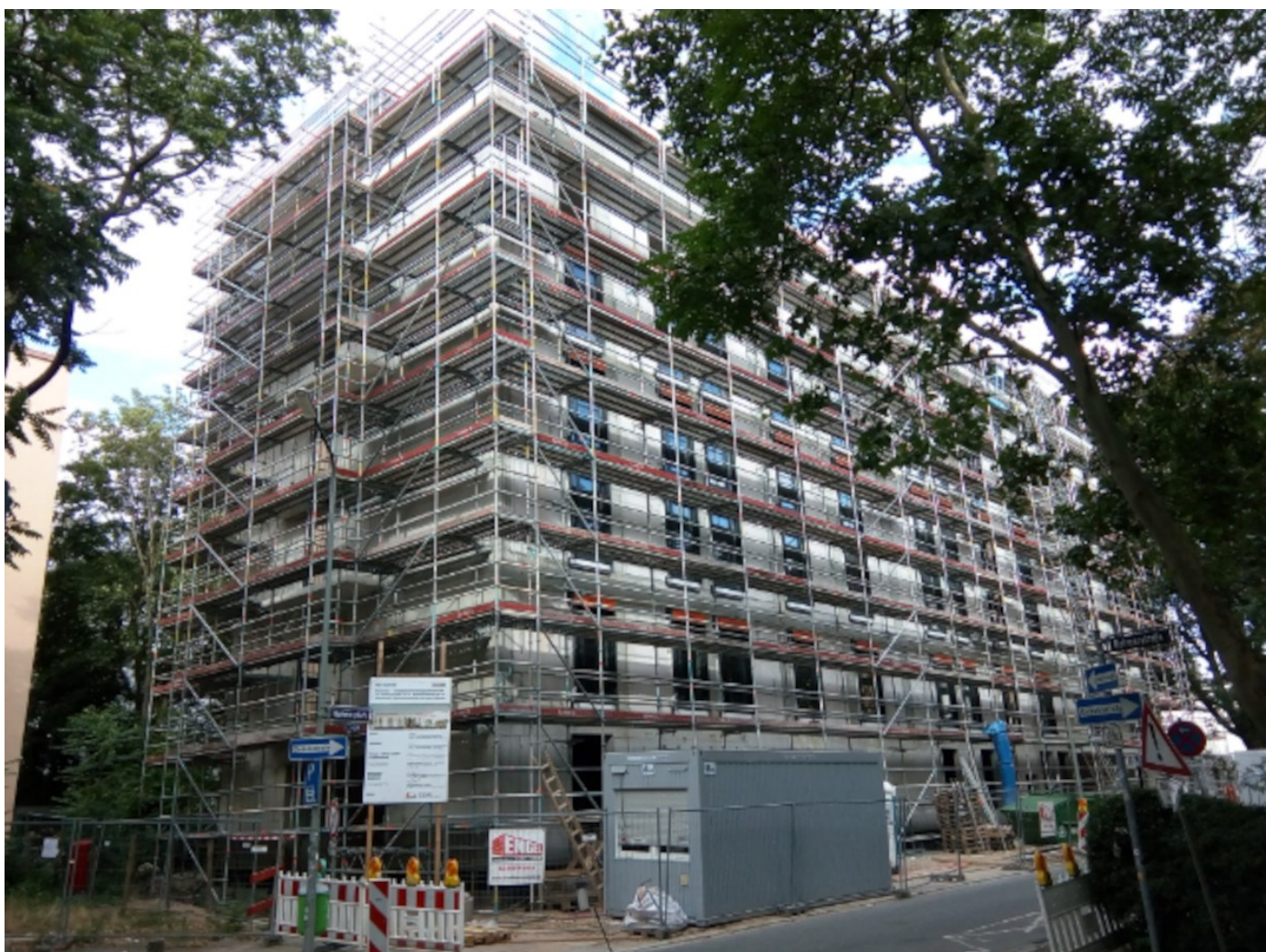
Kita-Neubau mit Studentenwohnheim am Rohmerplatz in Frankfurt
