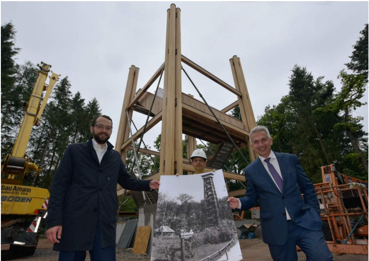
Montage des Goetheturms (v.l.): Baudezernent Jan Schneider, Projektleiter Tobias Döbele von der Firma Holzbau Amann und Oberbürgermeister Peter Feldmann
