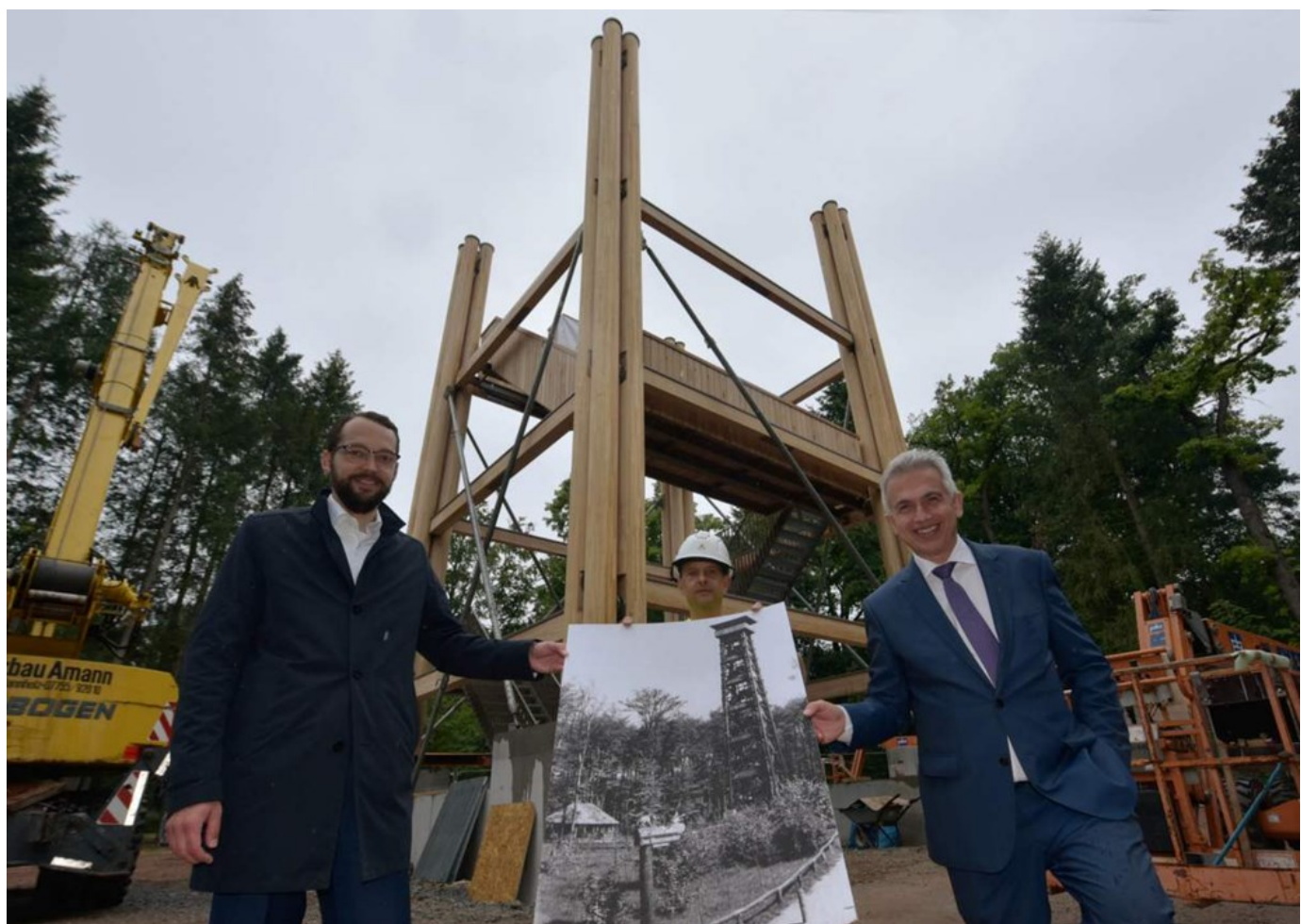
Montage Goetheturm mit Baudezernent Jan Schneider, Projektleiter Tobias Döbele von der Firma Holzbau Amann und Oberbürgermeister Peter Feldmann
