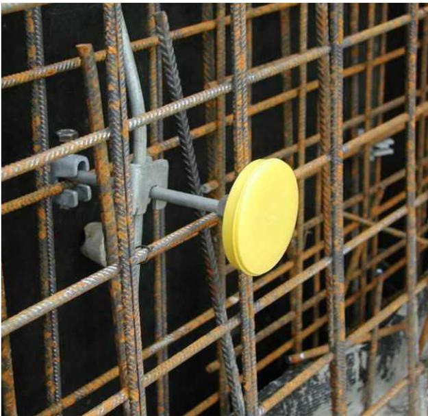
**B**ei jedem Neubau ist ein Fundamenterder zu installieren. Isolationsfehler oder andere Mängel in einem elektrischen Leitungssystem können ungünstige Wirkungen auf andere leitfähige Systeme haben, z. B. auf die Gas- und Wasserinstallation, Zentralheizungssysteme, Antennenanlagen oder Anlagen für Haus- und Telekommunikation. Der Fundamenterder ist unverzichtbar für den sicheren Betrieb der elektrischen Anlage eines Gebäudes und damit
