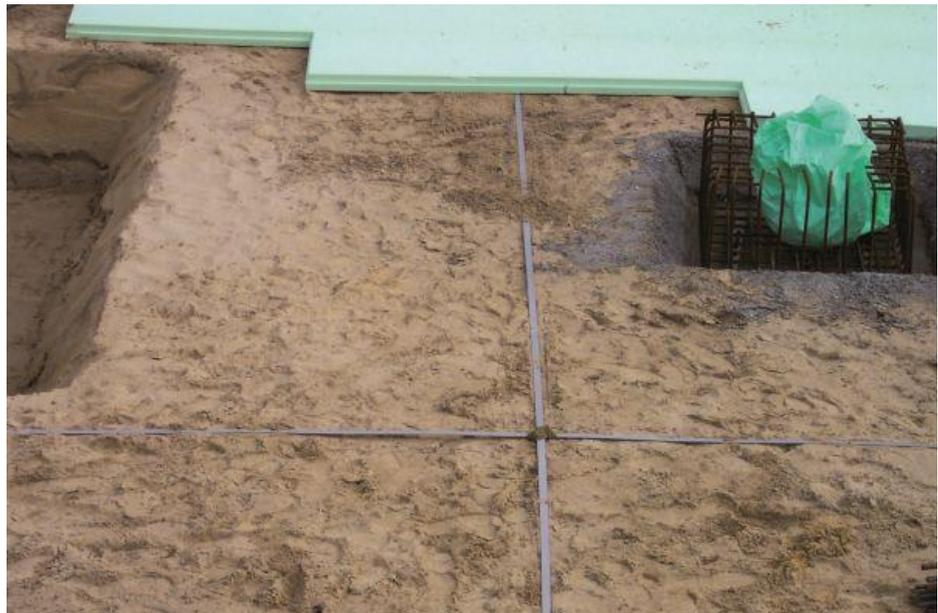
in der Bodenplatte verbunden. Im Ernstfall wird so die Überspannung gleich unter die Bodenplatte und ins Erdreich geleitet. Bauherren sollten bei ihren Baustellenbesuchen auf diese Details achten und im Zweifel den unabhängigen
