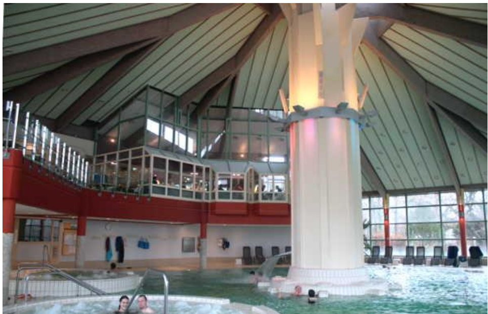
Kegeldach und Mittelstütze, Blick ins Solebad
