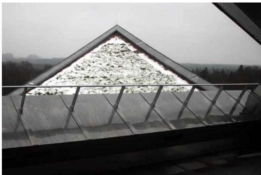
Dachbegrünung über dem Portal am Haupteingang. Der Rasen soll dann im Sommer mit Handsicheln in der Schräglage gemäht werden.
