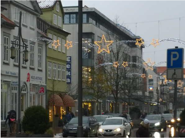
CEKA Kaufhaus, Gebäude mit Flachdach ursprünglich erbaut im Bauhausstil
