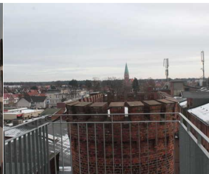
Aussichtsbalkon auf dem Turmdach
