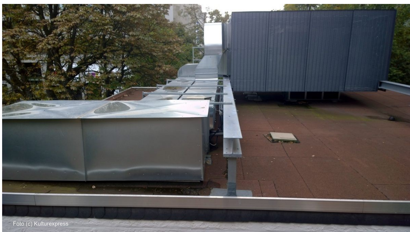
Lüftungsanlage auf dem Dach
