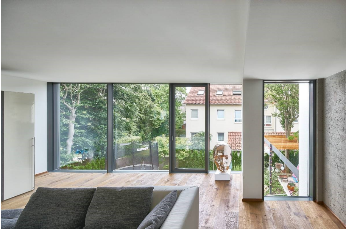
Die Aluminium-Glas-Fassade mit integriertem Öffnungsfeld und rahmenloser Glasbrüstung aus Verbund-Sicherheitsglas wurde hoch wärmeisolierend ausgeführt
