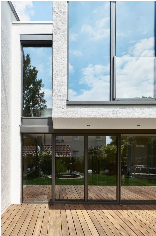
Gläserne Fuge am Schnittpunkt zum angrenzenden Gebäude
