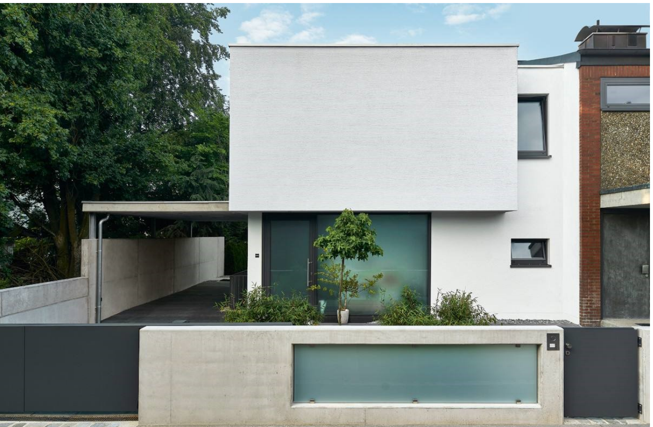
Der Boden des Obergeschosses kragt seitlich aus und bildet die Überdachung eines Carports
