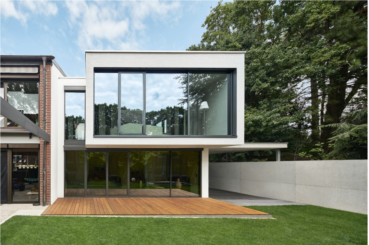
Die Fassade zum Garten: filigran profilierte großformatige Glasflächen, gerahmt durch verputzte Strukturen. Der Kubus des Obergeschosses ist in Holzbauweise erstellt, Foto (c) Christian Eblenkamp
