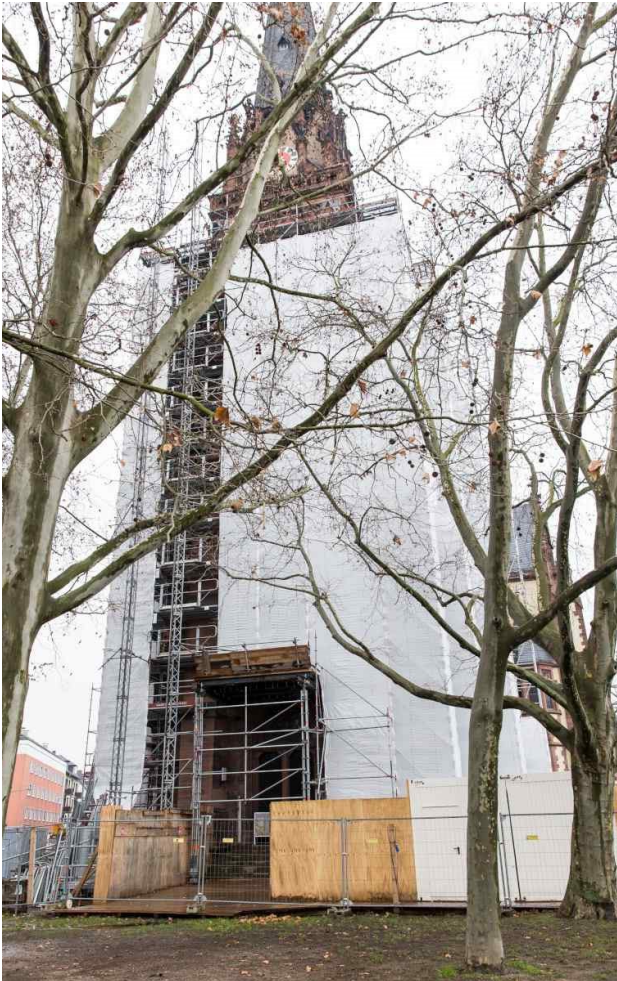
Der Turm der Dreikönigskirche wird derzeit eingerüstet (Ausschnitt)
