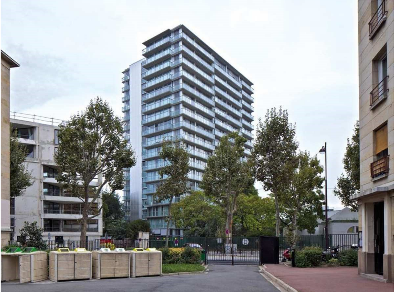
Umwandlung von 100 Einheiten, Tour Bois le Prêtre, Sozialer Wohnungsbau (mit Frédéric Druot) 2011 Paris, Frankreich
