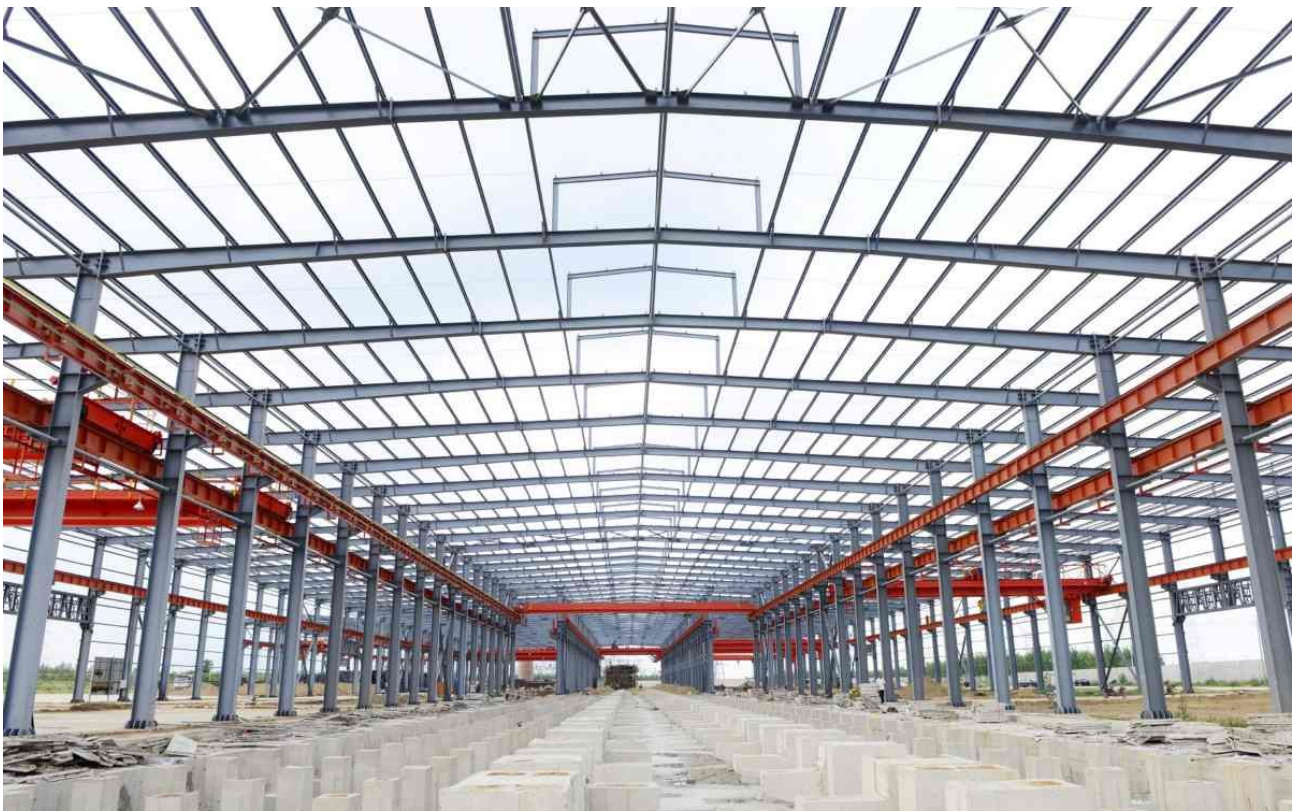
Brandschutz für Großprojekte in der Batterie- und Elektrofahrzeugfertigung, Foto (c) dhz2014 / 123RF.com
