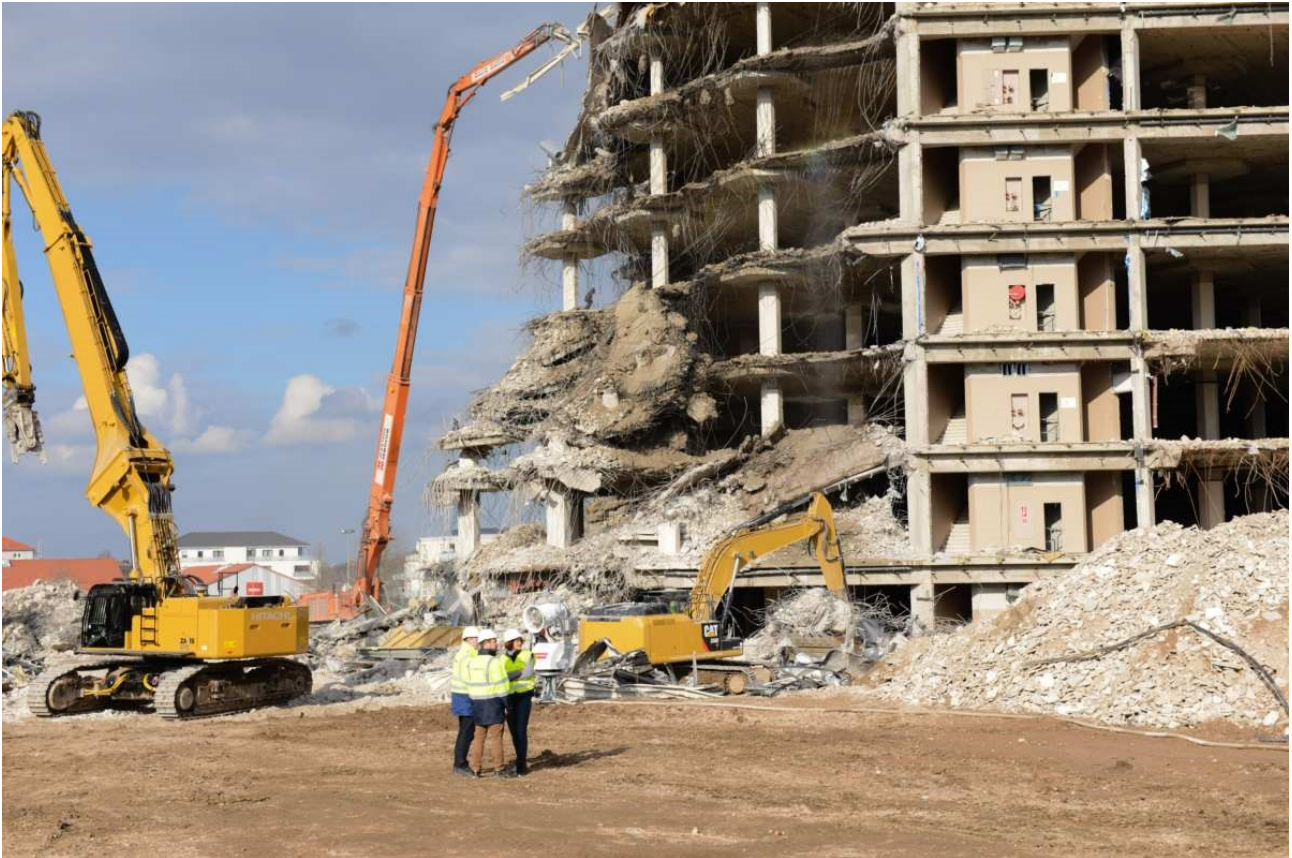
Im Forschungsprojekt RECBest werden sichere Verfahren für die Erfassung von Schadstoffen im Gebäudebestand entwickelt, mit denen u.a. bei einem Gebäudeabbruch das Recyclingpotenzial von Baustoffen besser ausgeschöpft werden kann
