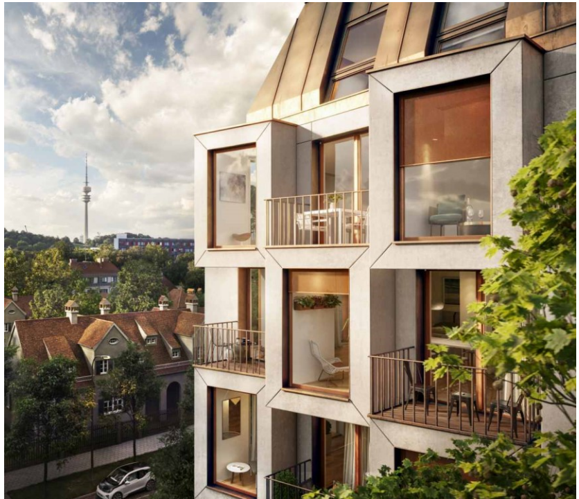
Die Fassade von Von B besticht durch außergewöhnliche Formsprache und einem Dualismus aus kupferfarbenem Metall mit rauem Glasfaserbeton
