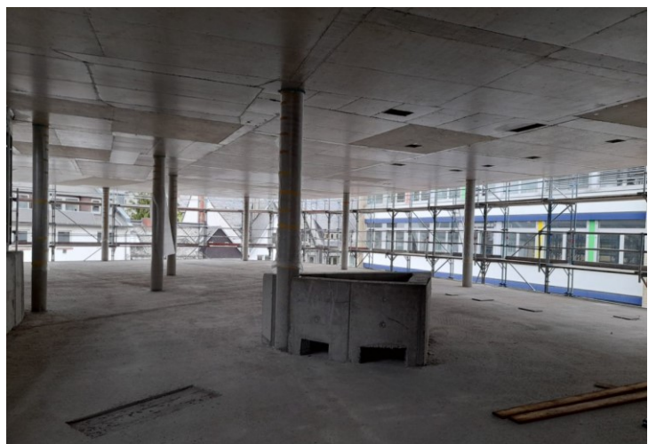
Obergeschoss mit zahlreichen Betonstützen, Aufbauten für Installations-schächte und Vorbereitung durchgehende Reihen mit schließbaren Fenstern
