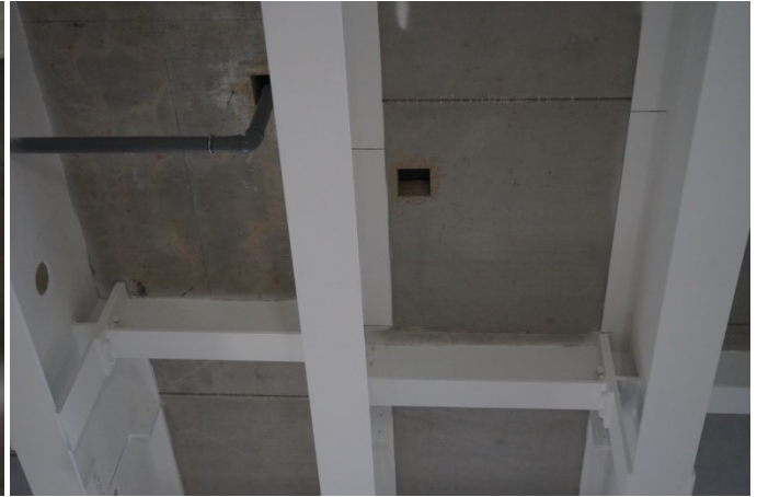
Die Turnhalle im EG mit weiträumigen Oberlichtern und der weißgestrichenen 1,75m hohen Stahlträgerdecke mit Zwischenraum für Installation und Leitungen
