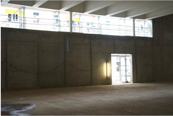
Die Turnhalle im EG mit weiträumigen Oberlichtern und der weißgestrichenen 1,75m hohen Stahlträgerdecke mit Zwischenraum für Installation und Leitungen
