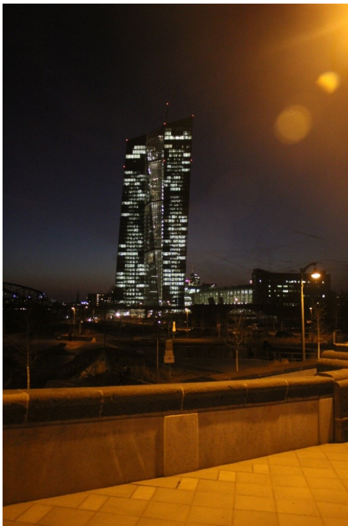
ECB Hochhaus bei Nacht
