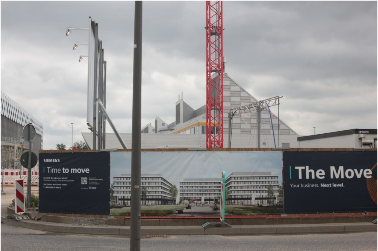
Großbaustelle Gateway Gardens, Juni 2021
