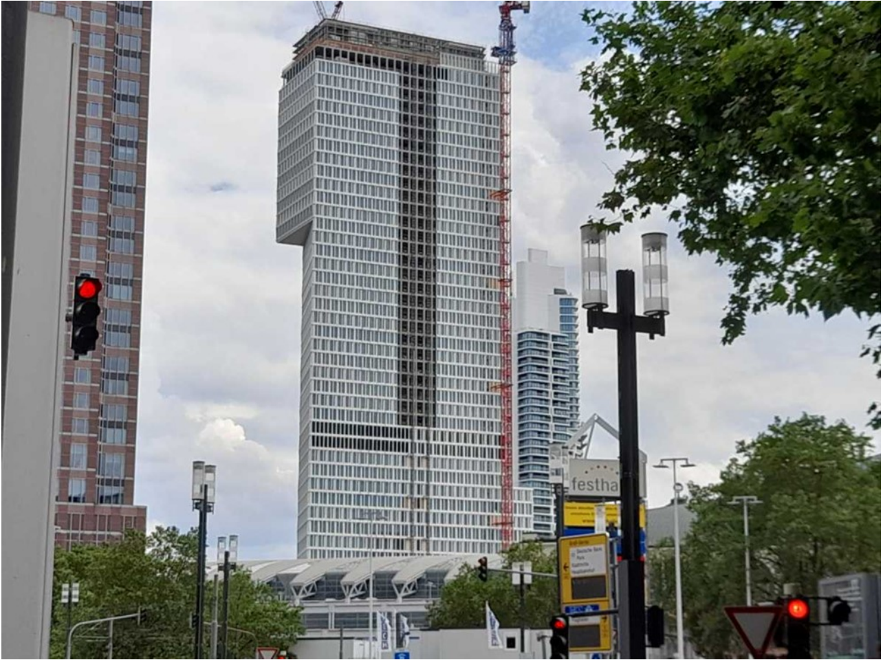
Bauphase Tower ONE im Juli 2021
