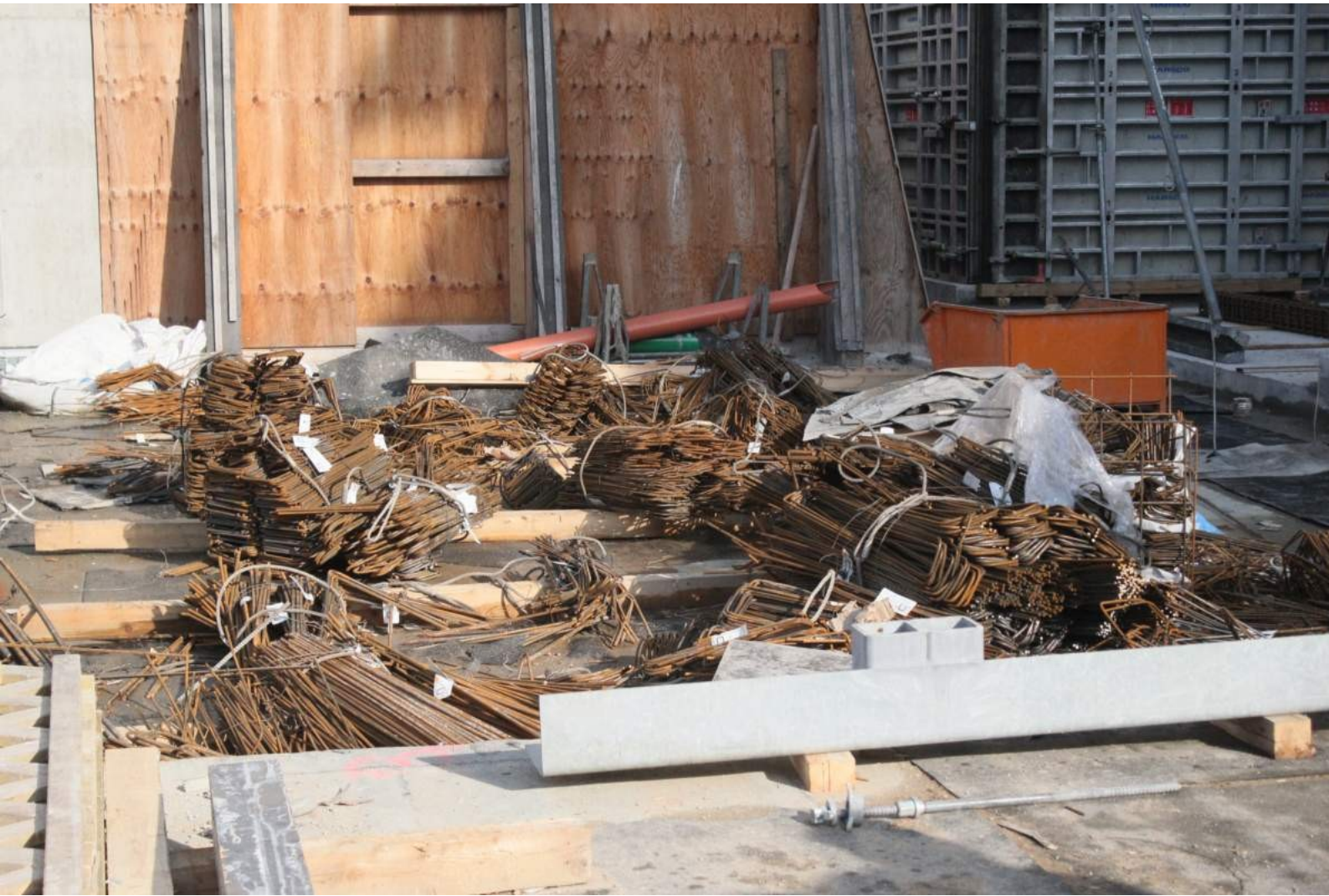
Bewehrungsstahl auf Lager
