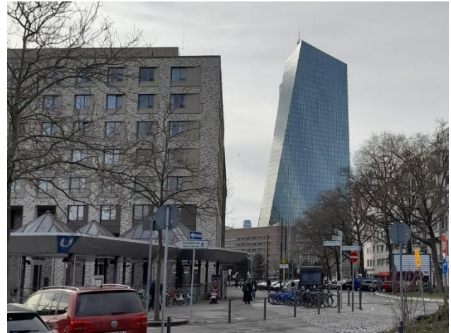
Monolithischer EZB-Turm vom Ostbahnhof aus, Februar 2024
