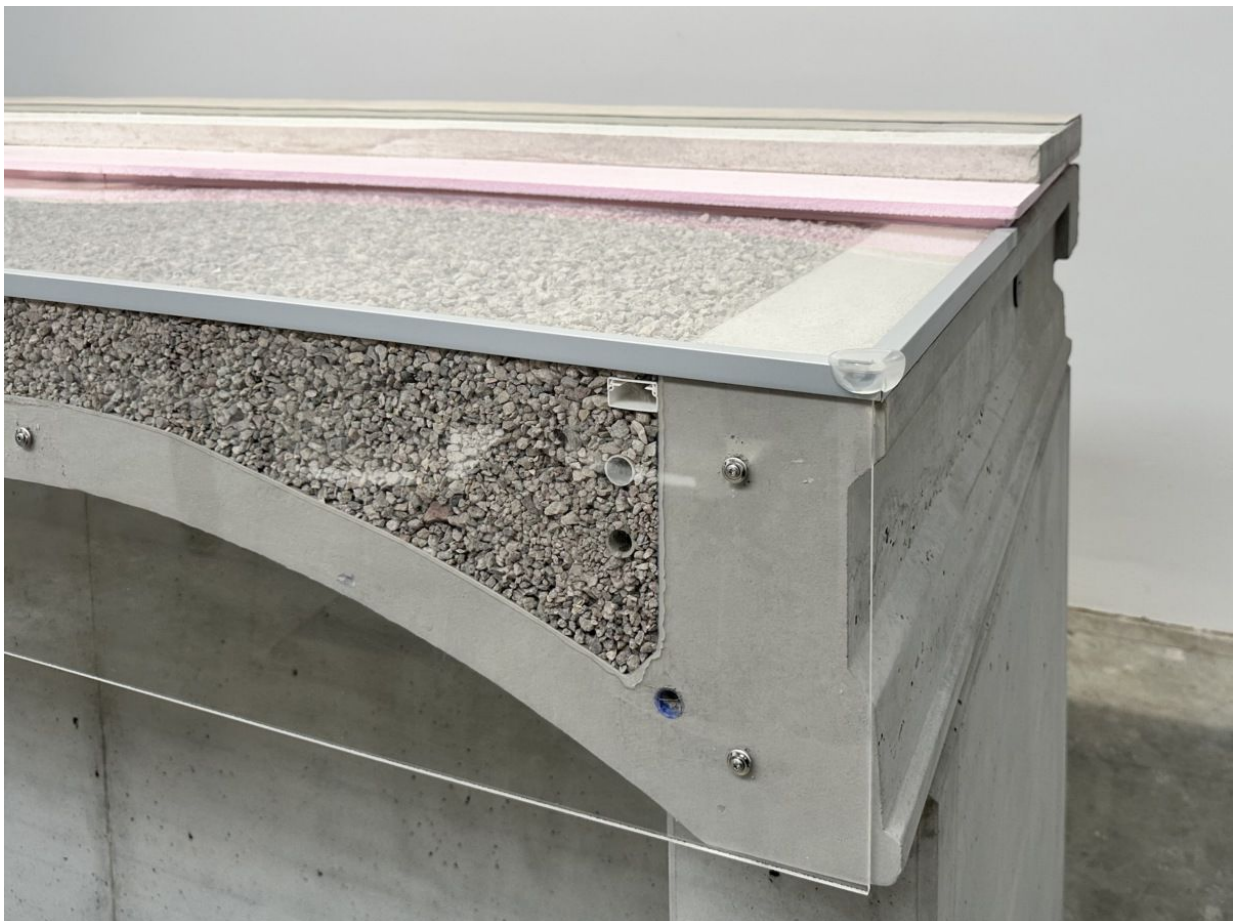
Im Showroom befindet sich neben dem 8,1m spannenden Element auch ein Schnitt durch die concap Kappendecke aus Beton 11
