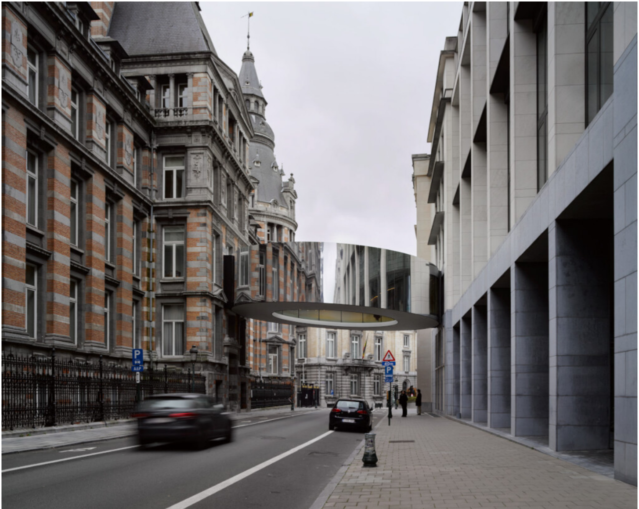
Tondo OFFICE Kersten Geers David Van Severen, Photo: Bas Princen
