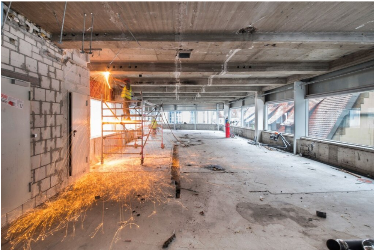
Umbauarbeiten Bürogebäude "Am Fruchtkasten"., Foto: Sarah Weiselowski
